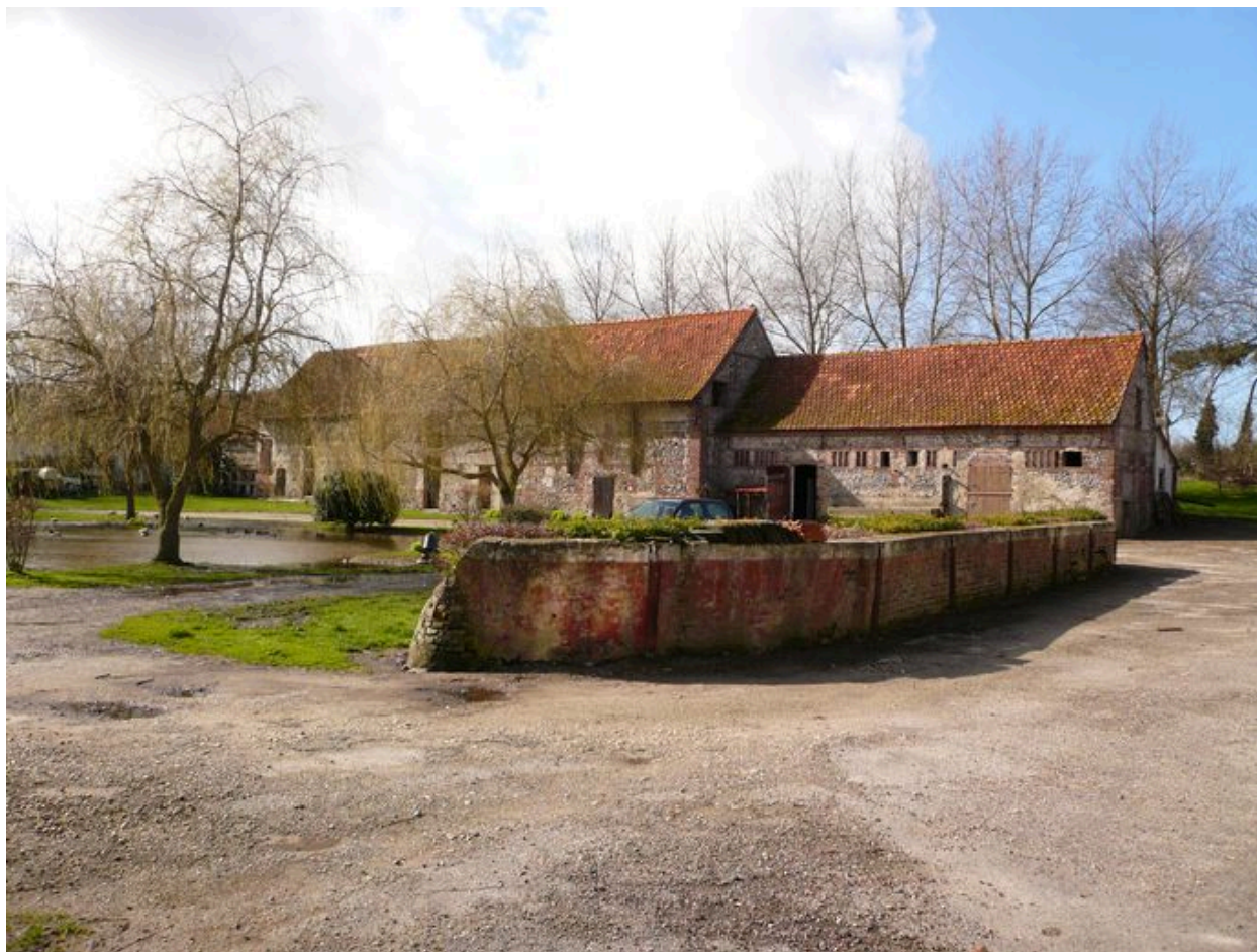
L'ancienne cosseterie de la ferme de Mayoc.
