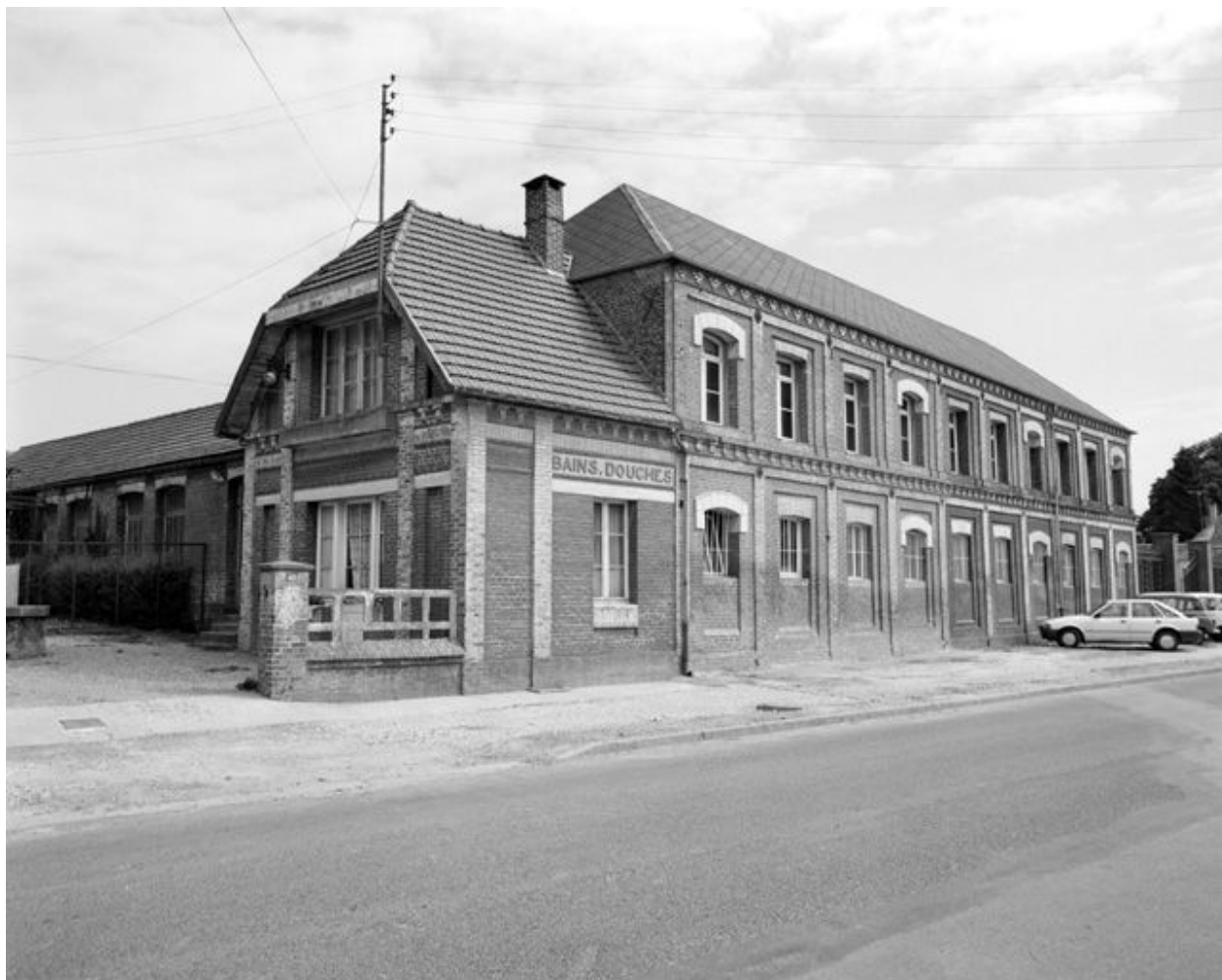
Bureau et atelier de fabrication, élévation antérieure.
