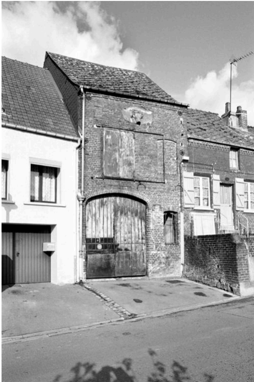
Vue de la façade sur rue.
