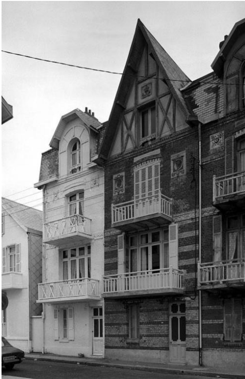
Vue d'ensemble des façades de n° 6 et 8 en 1981.
