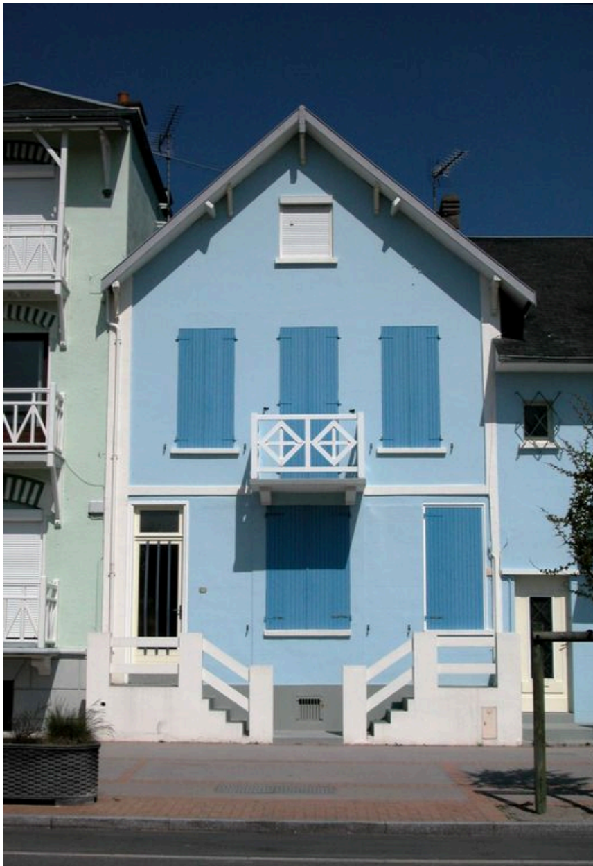
Retrait de rue aménagé d'un escalier d'accès (654 avenue de la Plage).
