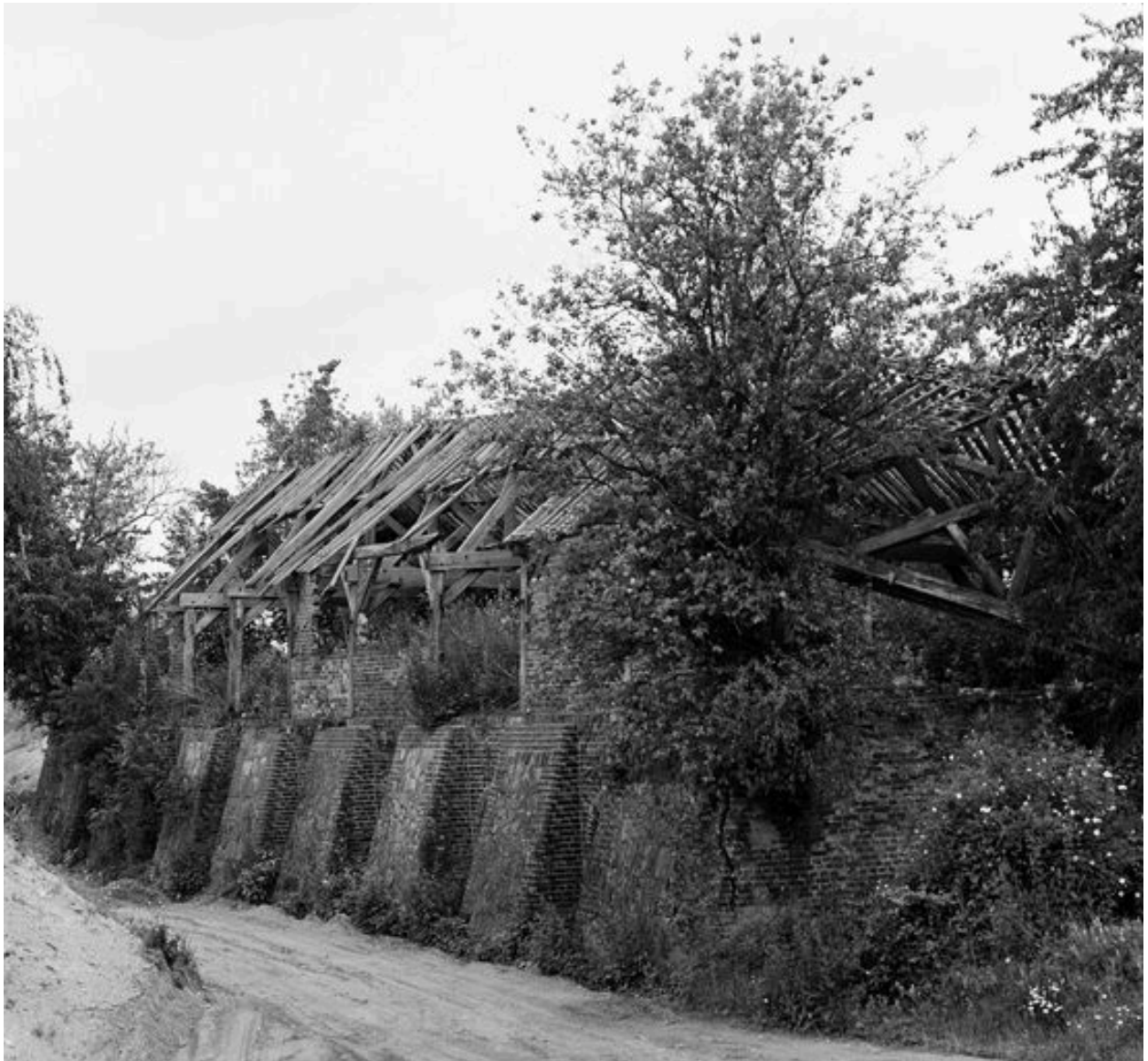
Four industriel de type Hoffmann, côté nord.
