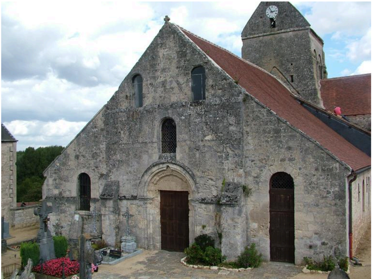
Vue générale de l'élévation occidentale.
