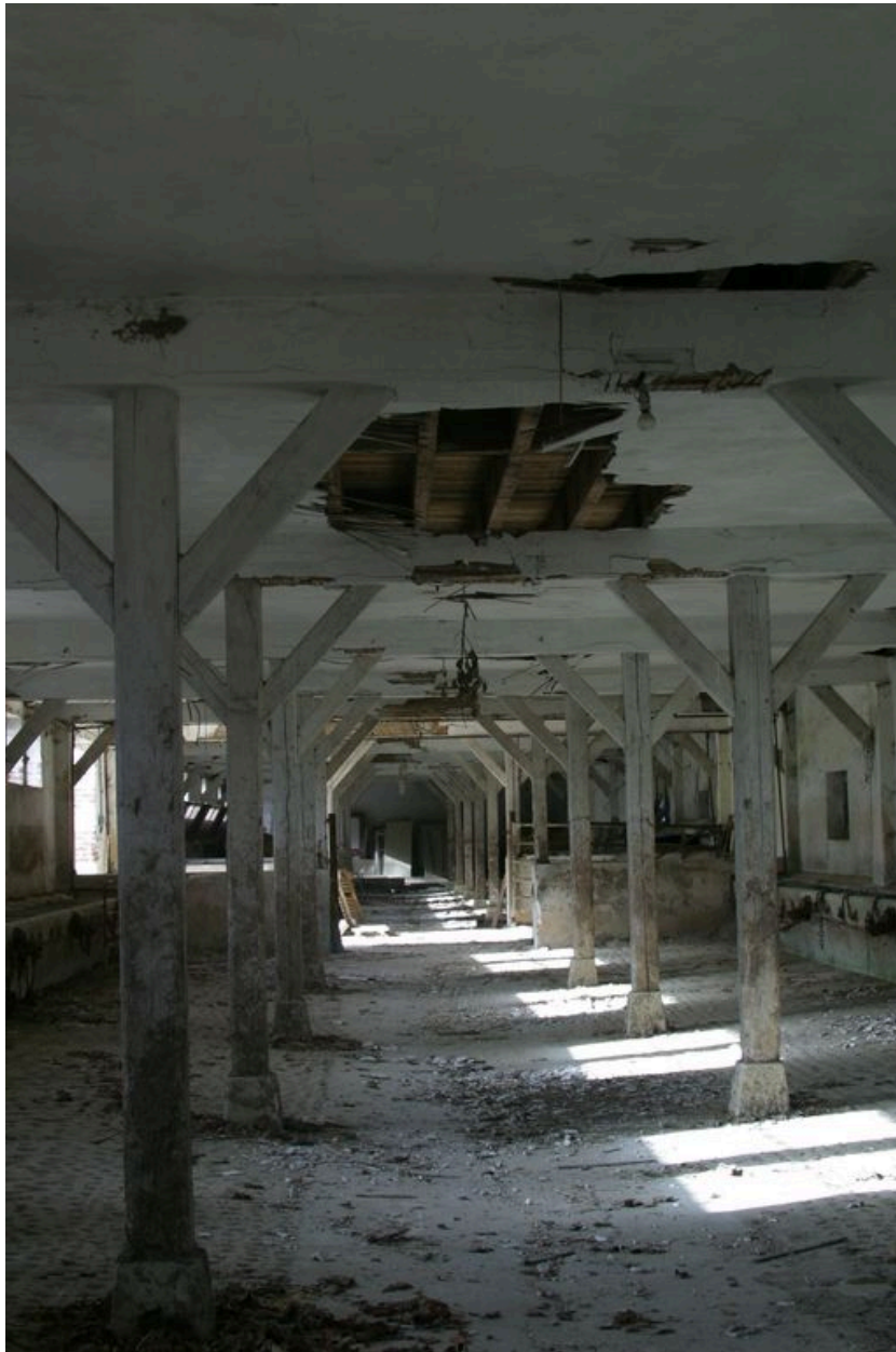
Vue intérieure de l'étable.
