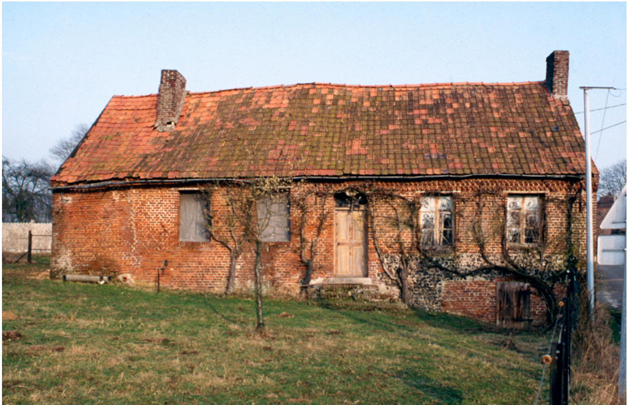
Vue d'ensemble de la façade.
