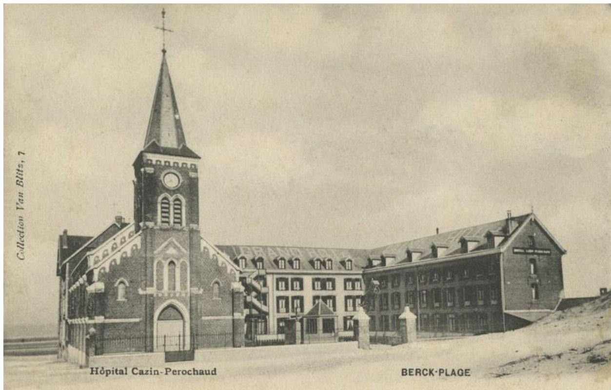
Élévation postérieure, vue générale prise de trois-quarts gauche avec la façade de la chapelle au premier plan. Carte postale, 1er quart 20e siècle (coll. part.).
