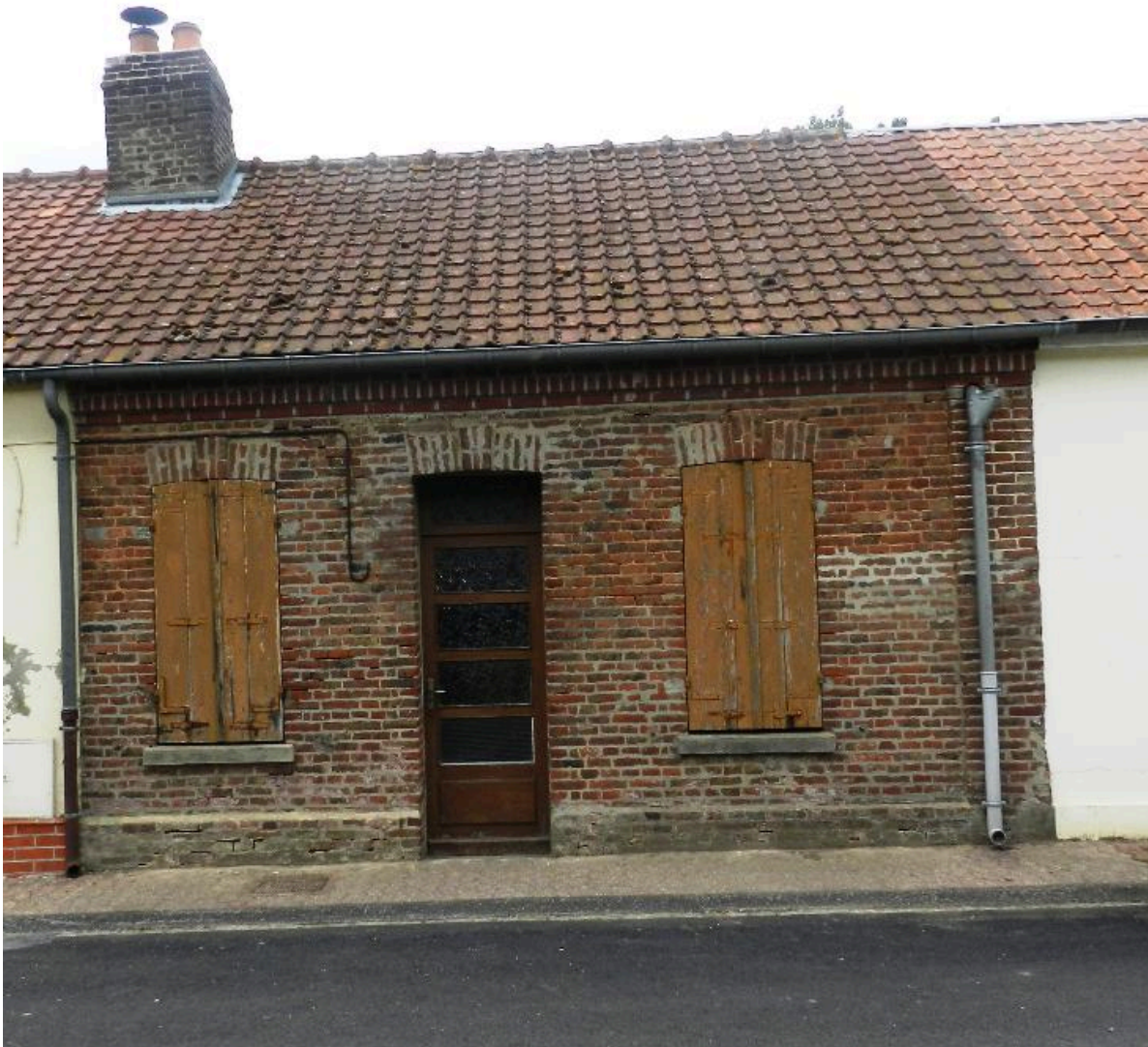
Façade d'un des logements.
