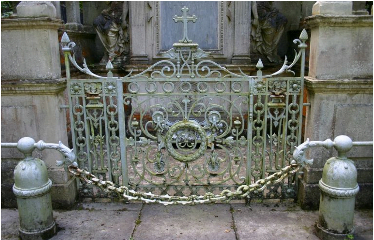
Grille de clôture antérieure en fonte ouvragée.
