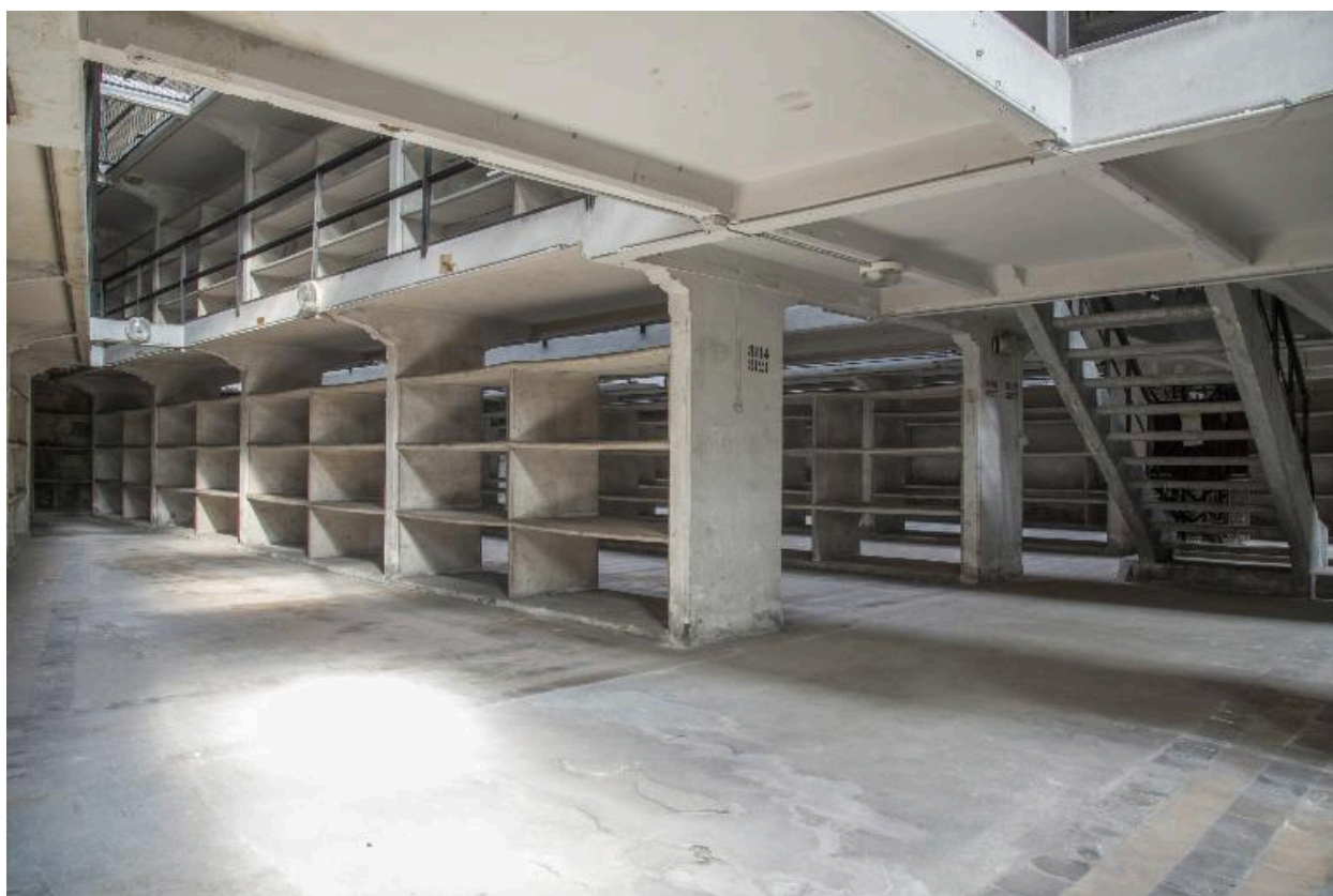
Bâtiment du dépôt, rez-de-chaussée : vue de l'extrémité ouest du vaisseau 4 et dessous de l'escalier.
