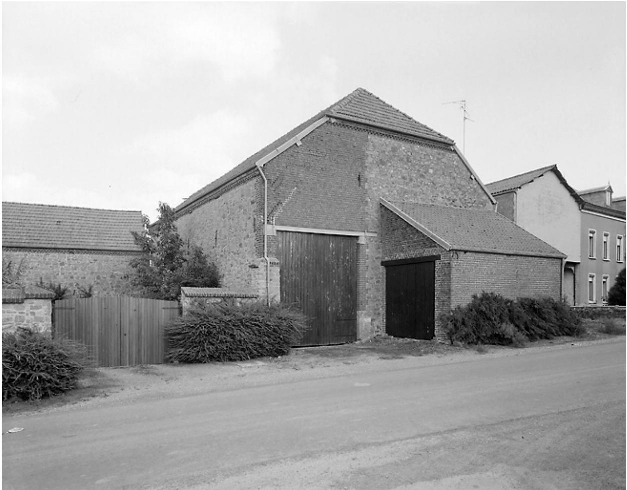
Vue de la grange.
