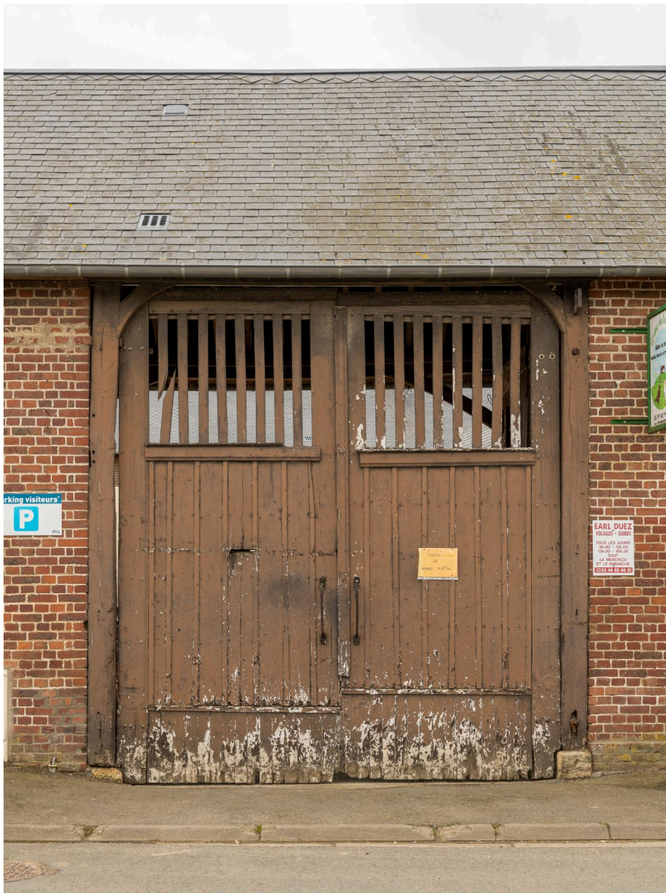
Entrée charretière, n°365 de la rue de Clermont, vue prise depuis le nord.
