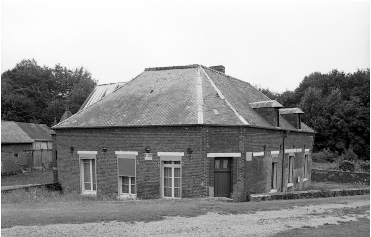
Vue d'ensemble du logis depuis le nord-ouest.
