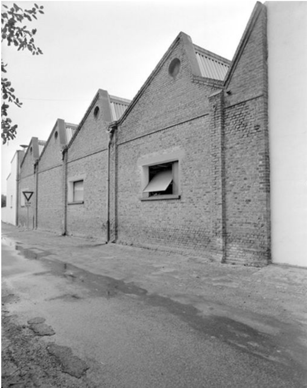
Atelier de fabrication, flanc est
