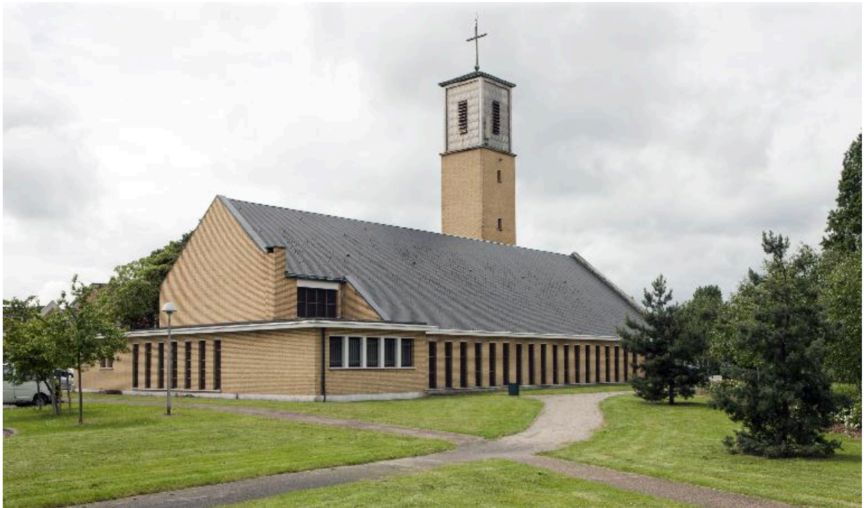
Élévation postérieure et flanc gauche de l'église.
