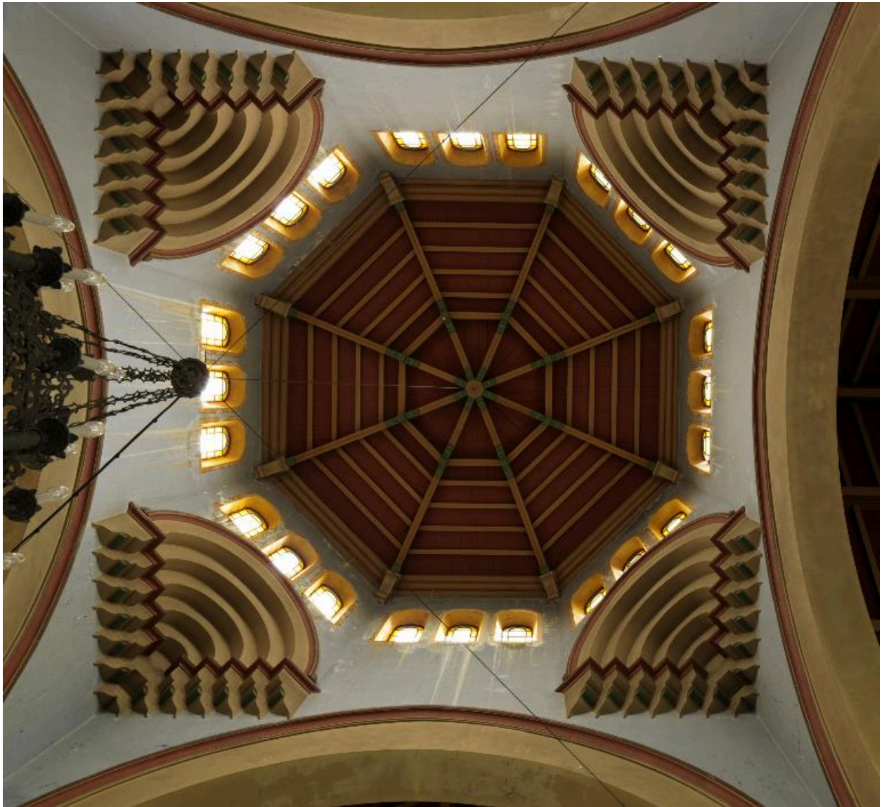
Vue de la coupole.
