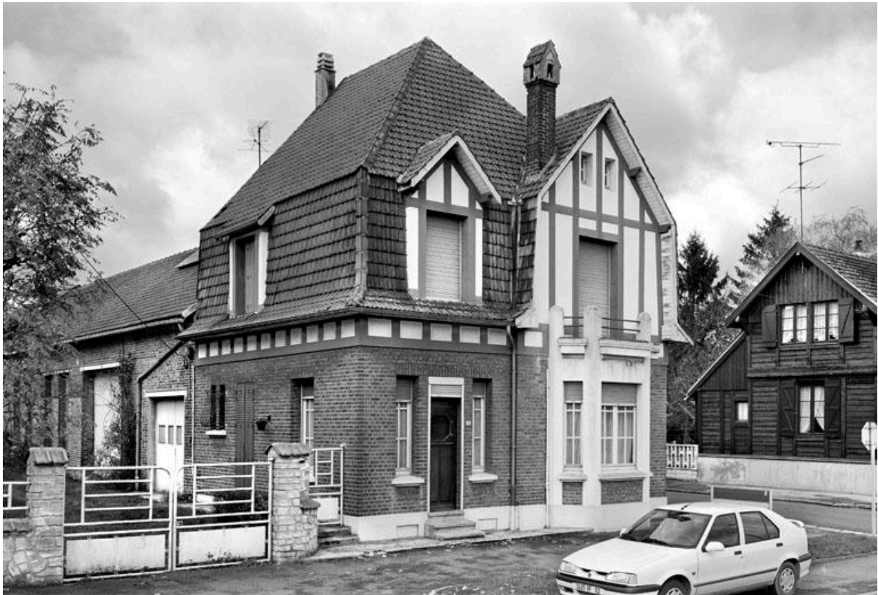
Vue de la maison, prolongée des locaux commerciaux sur la cour.
