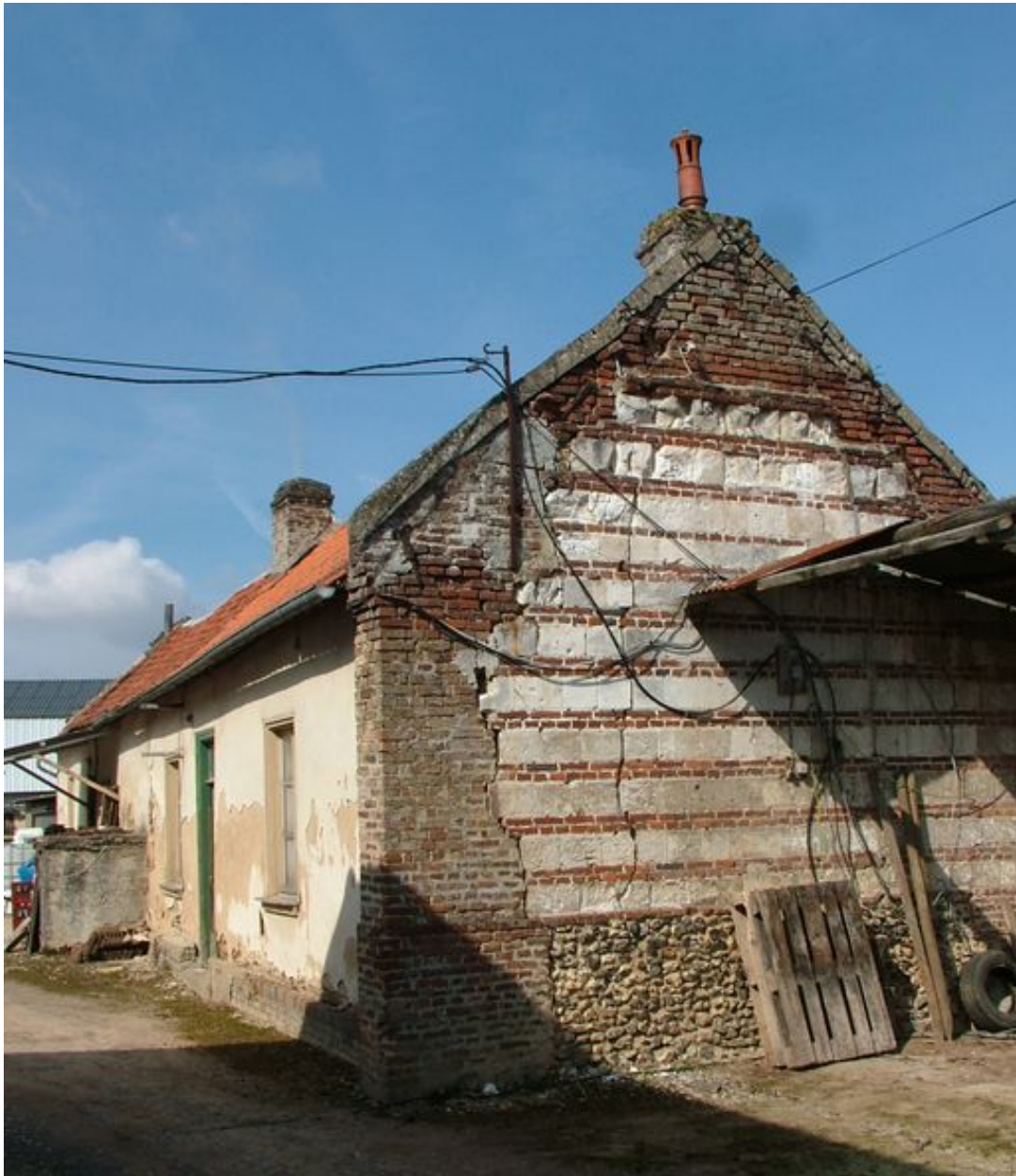
Havernas, pignon en brique et pierre d'un ancien logis de ferme, impasse Gaston-Moutardier, début du 19e siècle.
