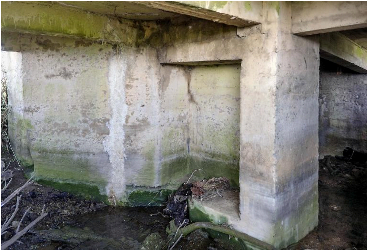
Vue intérieure, paroi est de la chambre de tir et accès à la soute à munition à droite.
