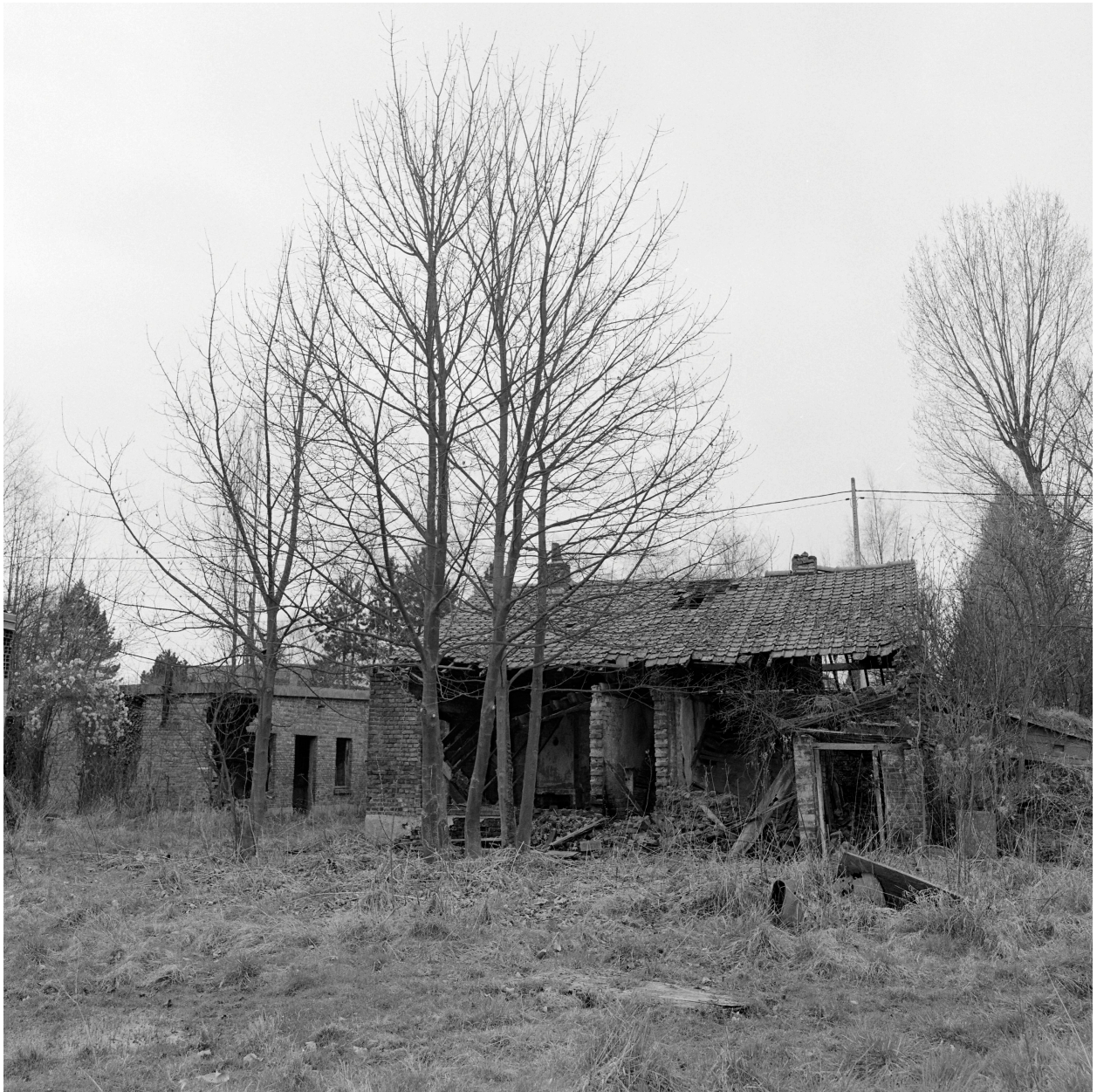
Vestiges des bureaux. Élévation postérieure.
