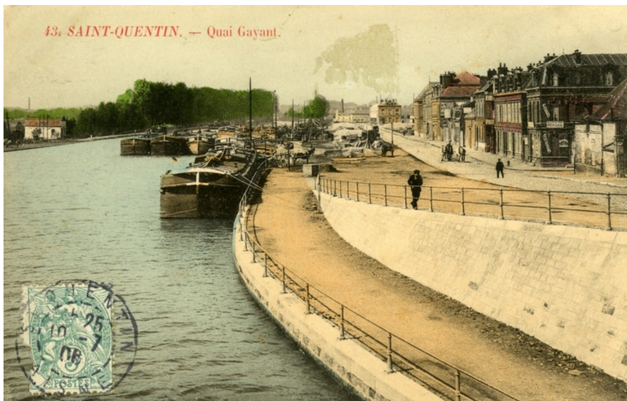
Vue générale du quai Gayant : au fond, l'ancien tissage Boca (BM Saint-Quentin).
