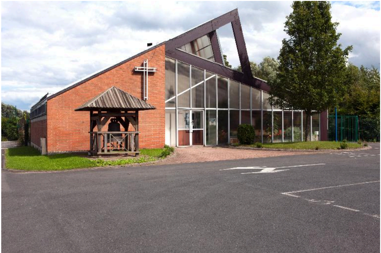
Vue de la façade occidentale.
