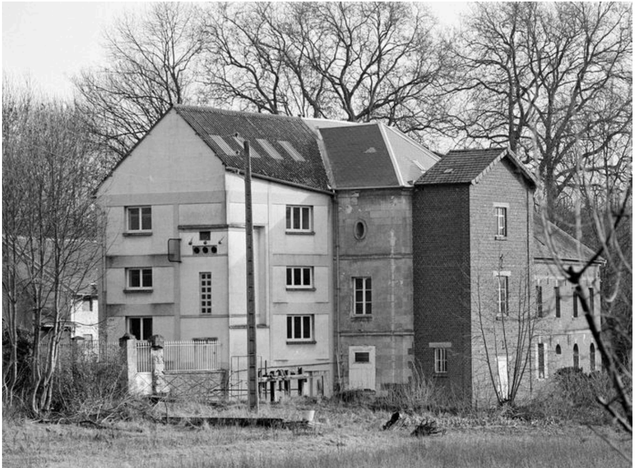
Vue générale, flanc nord ouest.
