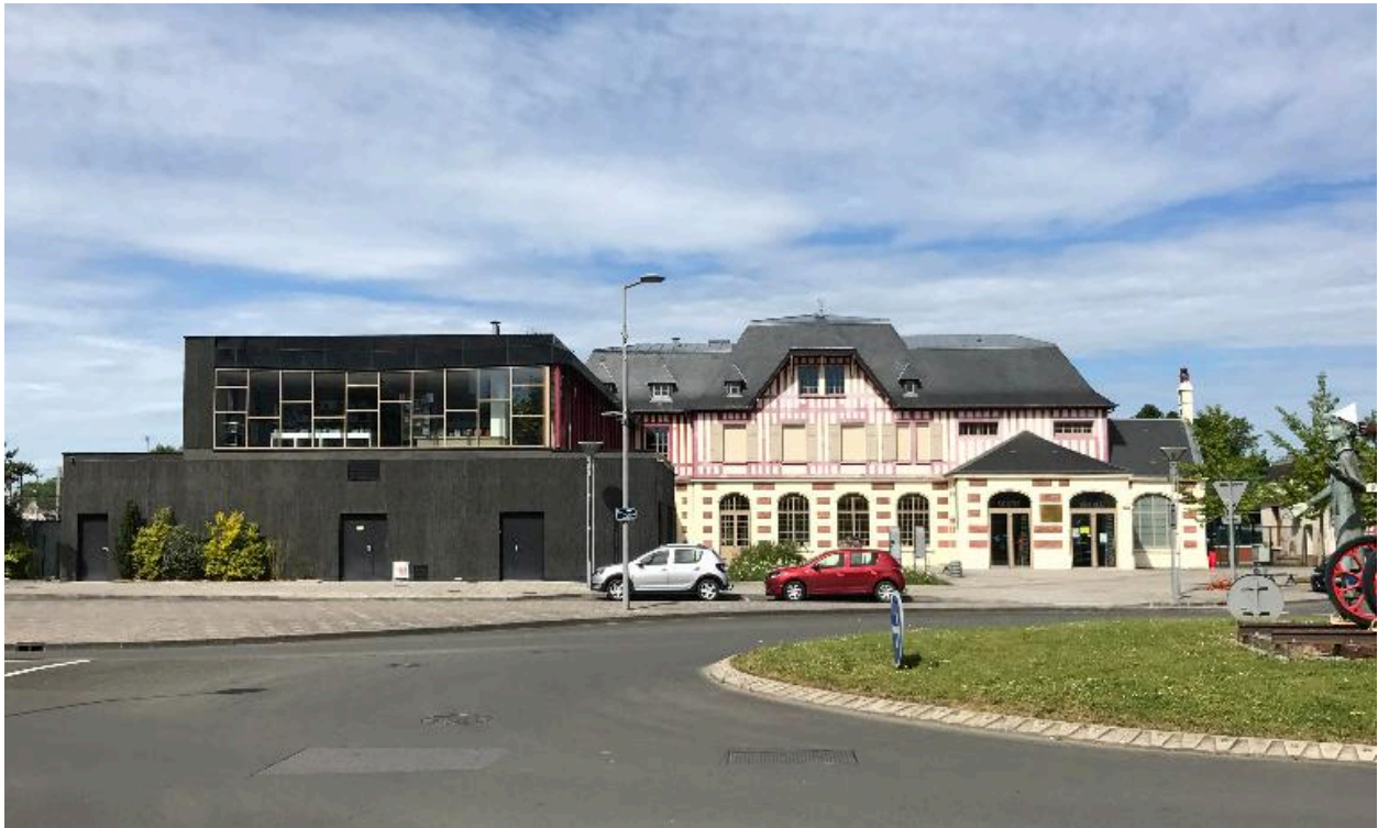
Vue générale de la façade principale de l'ancien buffet de la Gare et de son extension contemporaine.
