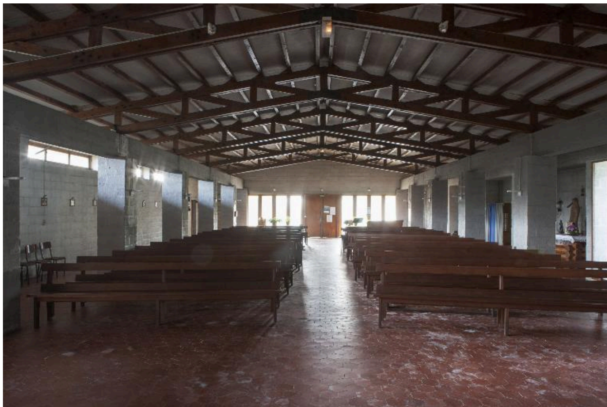
Vue générale depuis le chœur.
