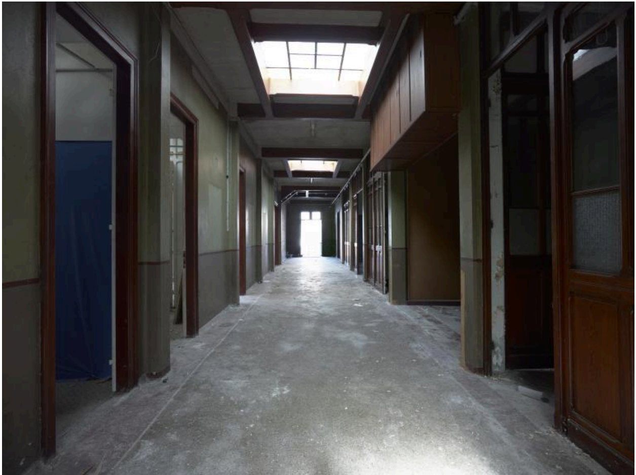
Bureaux. Couloir longitudinal vers l'est.
