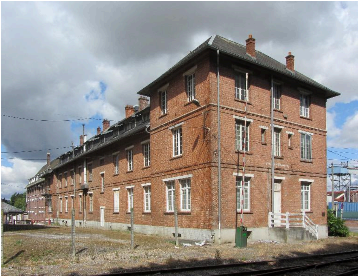
Vue d'ensemble de la façade postérieure de l'hôtel de la fabrique.
