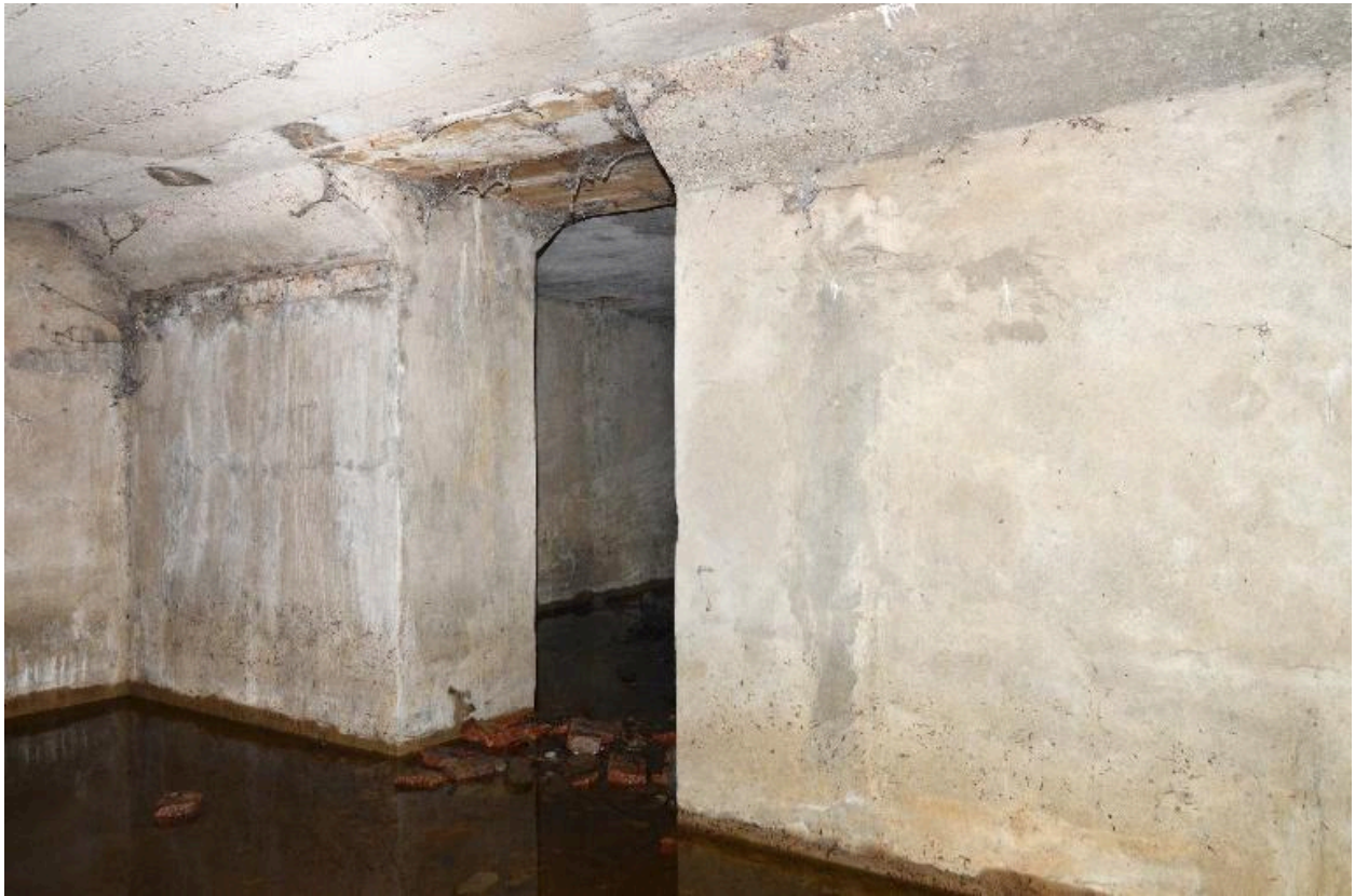
Porte de communication entre les deux salles sud
