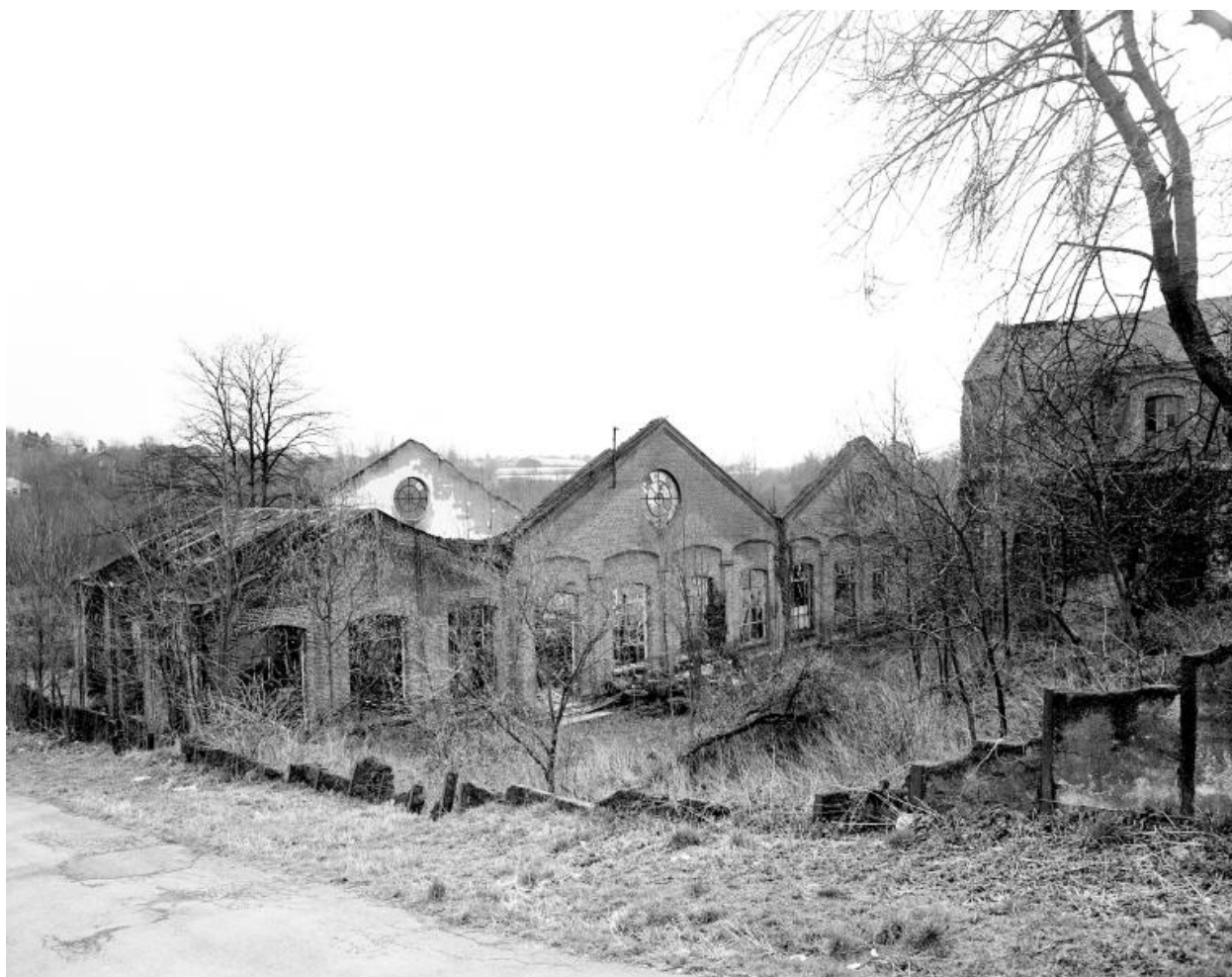
Vestiges de la sous-station électrique. Vue prise vers le sud.
