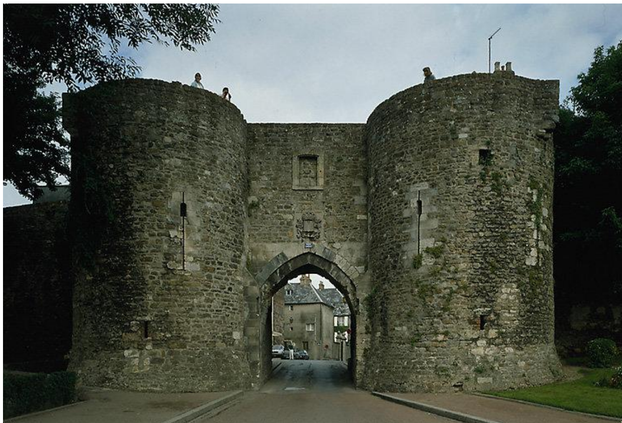
Façade sud sur boulevard.
