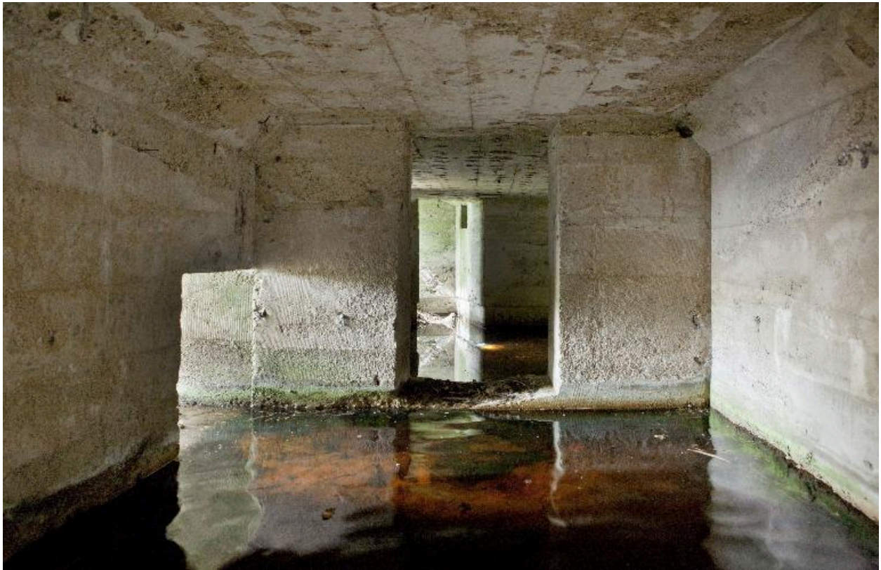
L'intérieur vers le sud ouest. A gauche le débouché de la resserre à mitrailleuse
