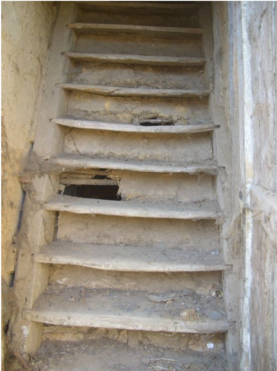
Vue de l'escalier de meunier menant aux combles.
