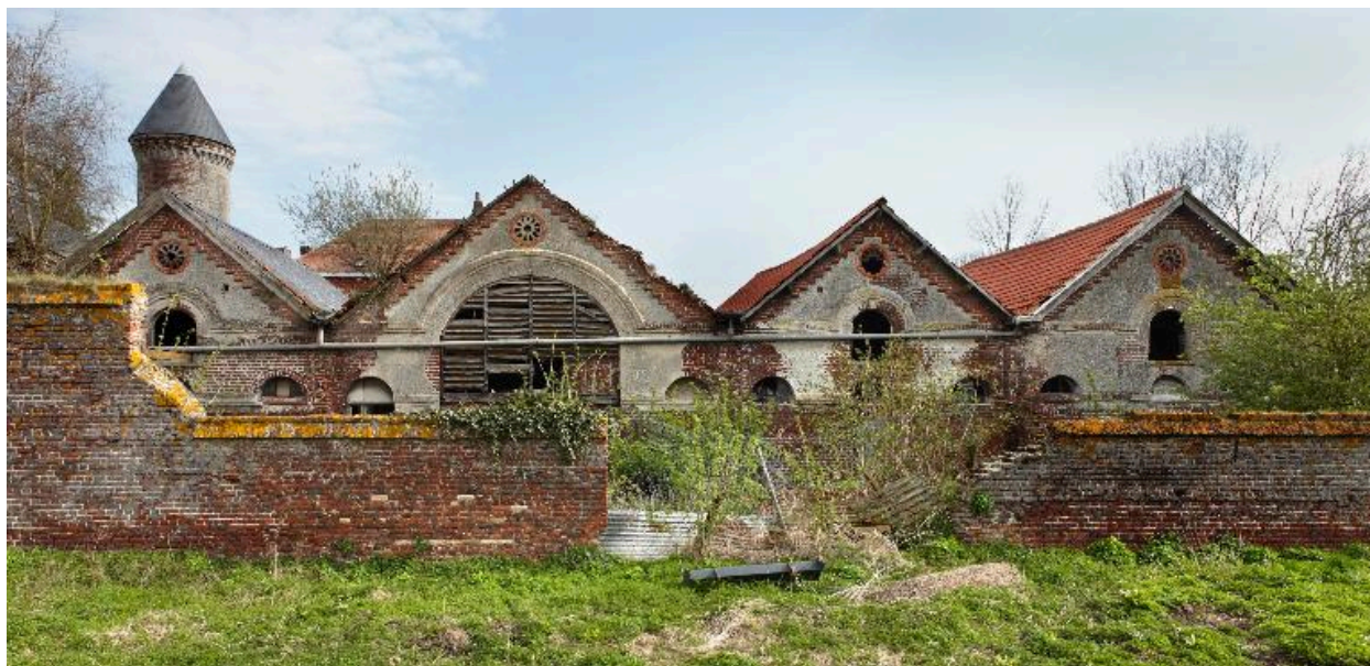
Vue générale des dépendances.
