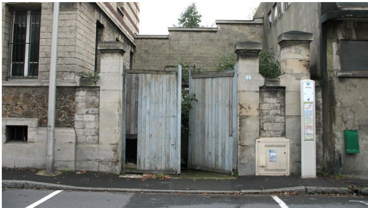
Portail d'entrée des bureaux.
