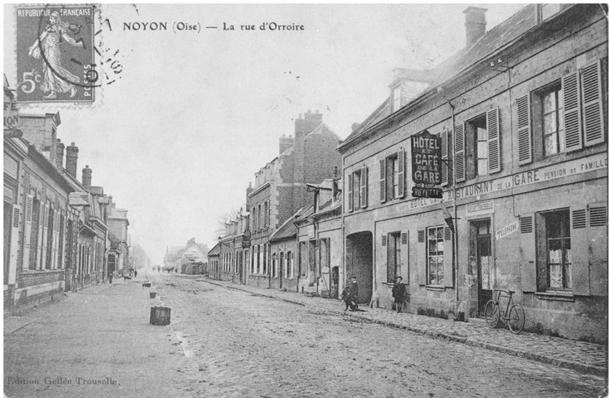
Rue d'Orroire, vers l'est. Avant 1914 (AP).
