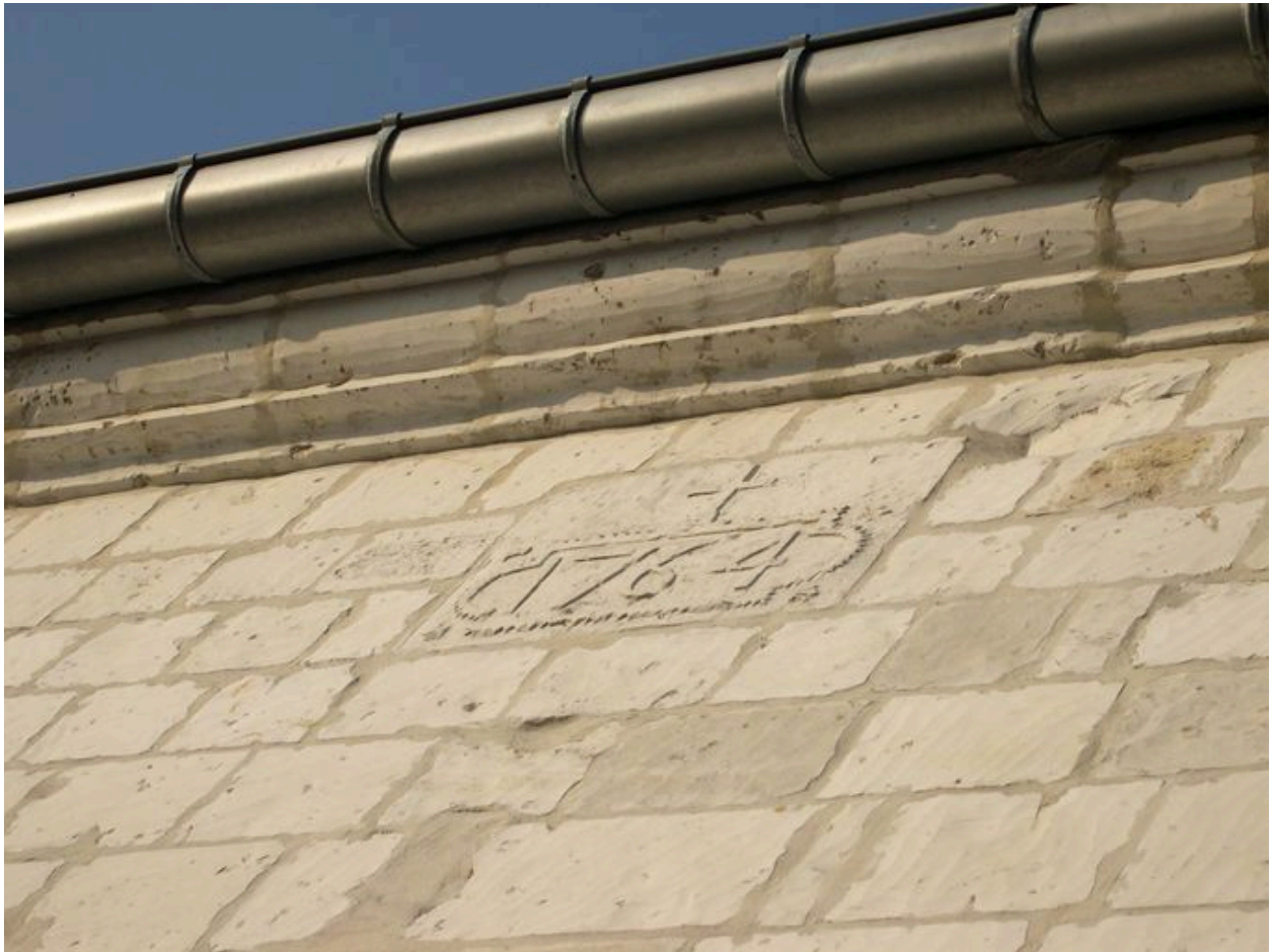
Vue de détail sur la date portée sur le mur est du choeur.
