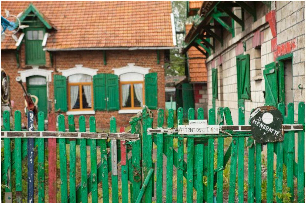
Vue partielle des bâtiments de ferme.
