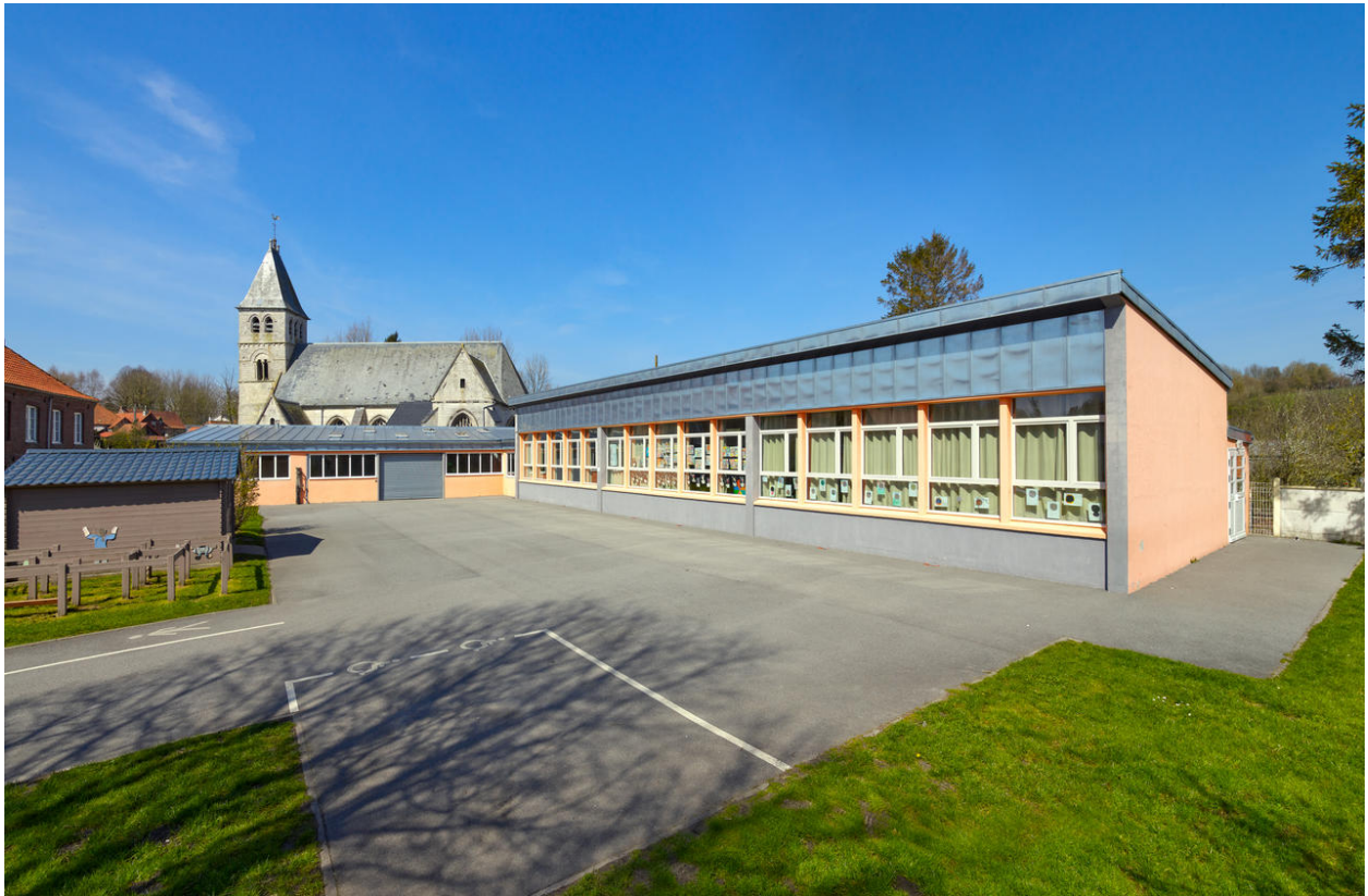
Vue générale depuis le sud.
