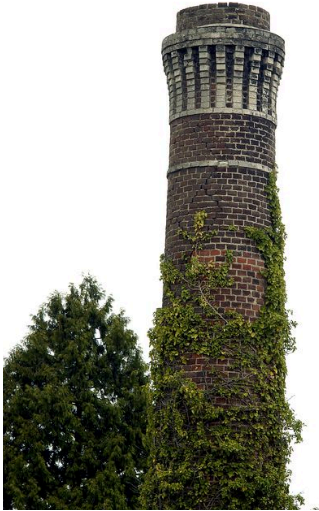
Détail du couronnement d'une des trois cheminées.
