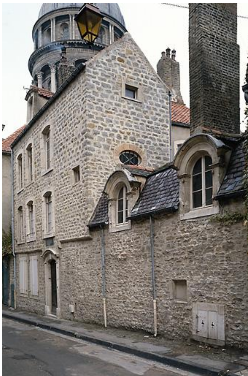
Vue d'angle sud-est après restauration.
