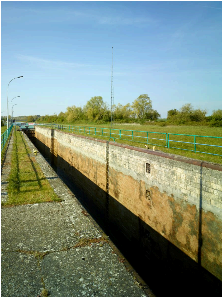
Vue générale depuis l'aval de l'écluse.
