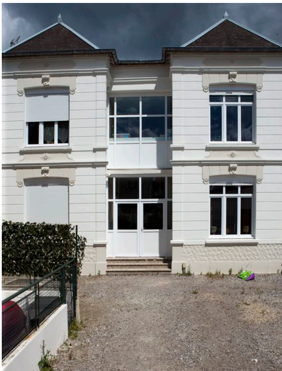
Vue générale du corps de bâtiment en fond de cour.
