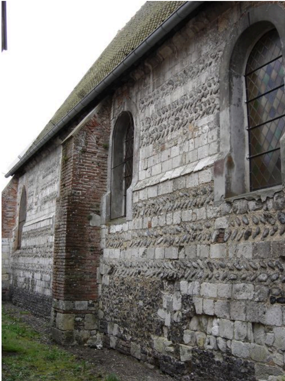
Vue latérale du mur nord.
