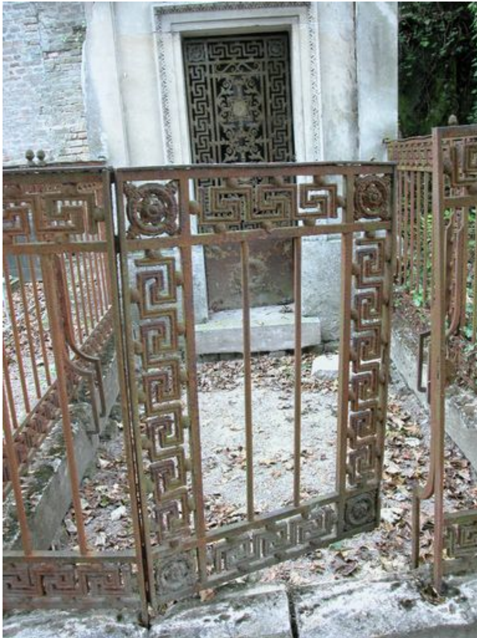
Vue de détail de la grille.
