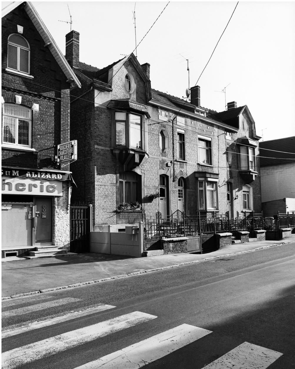
Vue générale de trois quarts prise depuis le sud.
