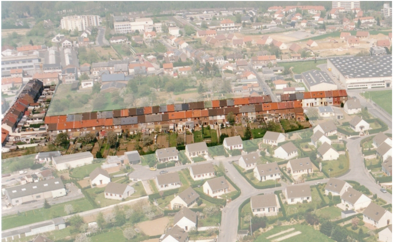
Vue aérienne vers 1989 (BM Saint-Quentin).
