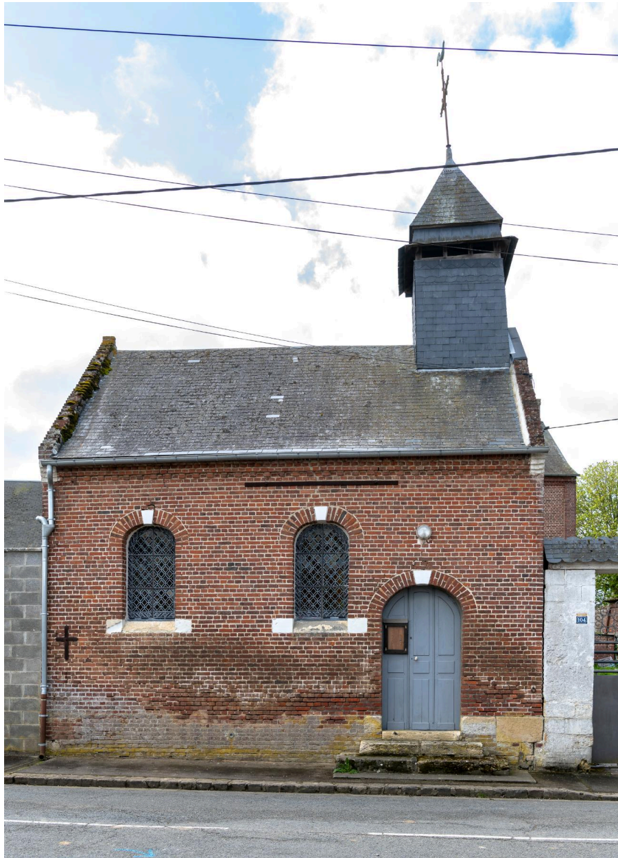
Chapelle, Grande Rue, vue prise depuis le nord.
